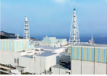
島根原子力発電所
