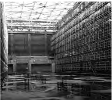
建設中の新総合体育館
